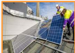
Kantoor Hemweg centrale 962 panelen
